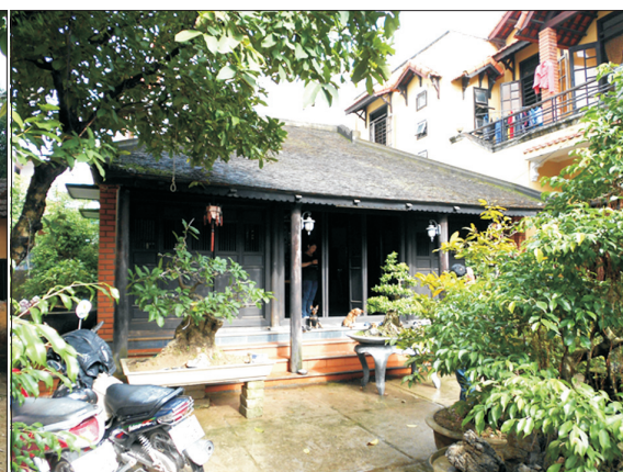
Hình 5: Cột hàng hiên bê tông giả gỗ ở ngôi nhà A19 (14/1 Lê Huân)
