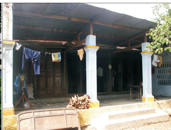
Hình 7: Dấu vết cột gỗ trên cột hiên nhà B21 (67 Lê Thánh Tôn).
