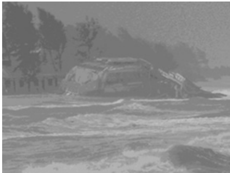
Hình 2: Bờ biển Thuận An bị xói lở và nhà bị đổ sập. Ảnh của nhóm đề tài do Trần Đình Lân làm chủ nhiệm, 2003.
