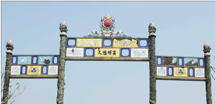
Hình 1: Pháp lam được phục chế để tu bổ nghi môn trước Điện Thái Hòa. Ảnh: Xuân Hoa sưu tầm.
