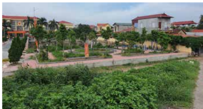
Hình 4: Các vườn hoa được đầu tư xây dựng nhưng ít được người dân hưởng ứng, công tác duy trì duy tu cảnh quan gần như bị bỏ ngỏ làm cho vườn hoa xuống cấp nhanh chóng. Vườn hoa trước UBND xã Trung Châu, Đan Phượng
