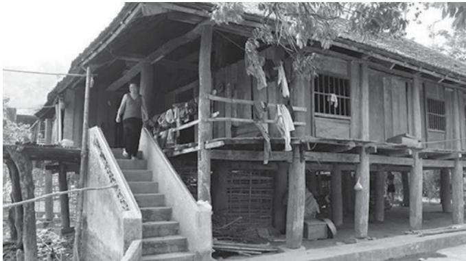
Hình 7: Nhà sàn gỗ với cầu thang và cột được bê tông hóa
