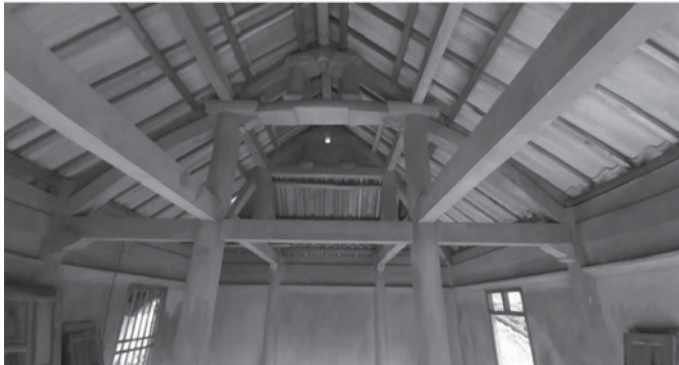
Hình 5, 6: Nhà sàn bê tông ở xã Yên Thượng, Cao Phong, Hoà Bình - Toàn bộ khung, cột, tường, sàn đều bằng bê tông
