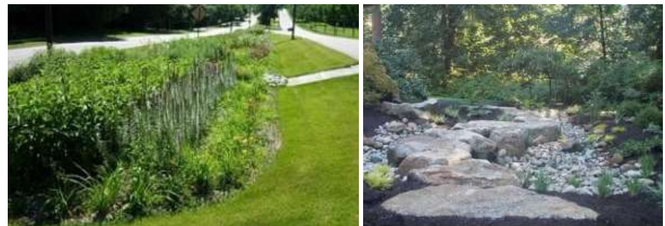
Hình 9. Các giải pháp hạ tầng bền vững, tăng khả năng thấm thấu bề mặt, hạn chế tốc độ dòng chảy thoát nước mặt là những biện pháp cải thiện đáng kể tình trạng úng ngập đô thị, nhất là các đô thị vùng cao như Sa Pa. (Trái) Hệ thống thu nước mặt dạng rãnh thu sinh thái (bioswale) (Nguồn: https://www.reliance-foundry.com ); (Phải) Tăng cường bề mặt tự thấm bằng giải pháp vườn mưa (rain garden). (Nguồn: https://www.envconst.com/ ).
