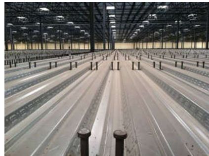
Hình 14. Hàn đỉnh thép trên sàn Deck
