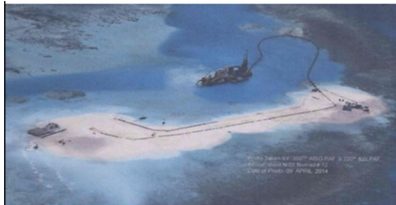
Hình 4: Hoạt động nạo vét tại Đá Tư Nghĩa
