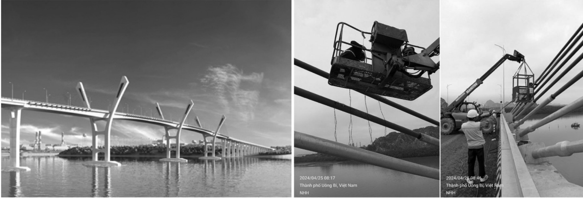
Hình 5: Tổng thể cầu Bến Rừng và đo dao động dây cáp ngoài ngày 25/04/2025
