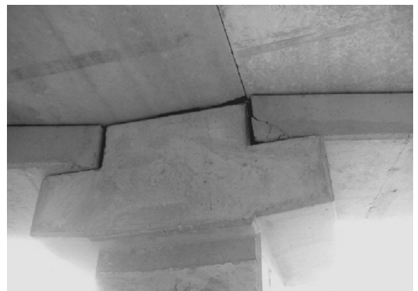
b) Nứt do ngăn cản tại liên kết giữa dầm và cột lắp ghép
