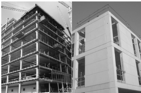
a) Khung xương bê tông cốt thép lắp ghép nhà nhiều tầng b) Ngôi nhà hoàn thiện sử dụng cấu kiện bê tông cốt thép lắp ghép Hình 2. Khung xương chịu lực và cấu kiện hoàn thiện bê tông lắp ghép được ứng dụng trong công trình Nhà ở dân dụng [2- 4]
