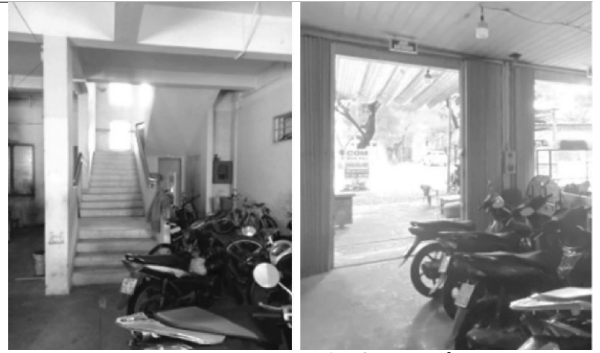
Hình 5: Các phương tiện xe máy đặt chắn lối thoát hiểm tại một chung cư khảo sát
