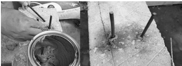
Hình 4. Sử dụng Sikadur liên kết chốt neo ngang vào dầm
