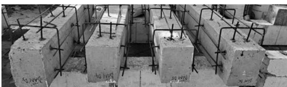
Hình 5. Lắp đặt các thanh thép ngang, thép dọc vào các mặt dầm
