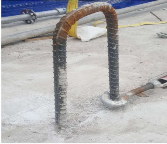
Hình 7: Vị trí ti thép, thép biện pháp
