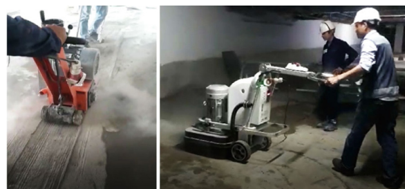
Hình 6: Đục tẩy, đổ bù và mài bề mặt bê tông sàn
