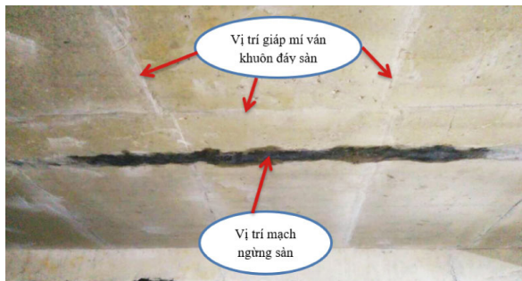
Hình 3: Vị trí giáp mí ván khuôn đáy sàn, mạch ngừng trần sàn
