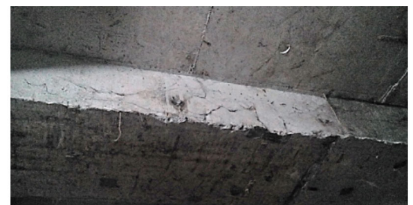
Hình 1: Thành và đáy dầm uốn lượn
