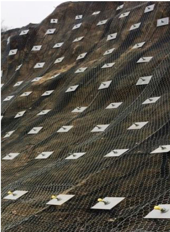
Hình 2.1. Hình ảnh sử dụng đinh đất
