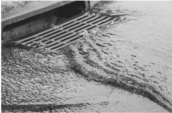
a) Tấm đan thu nước đặt kết hợp cửa thu nước kiểu hàm ếch ( https://www.istockphoto.com/ )
