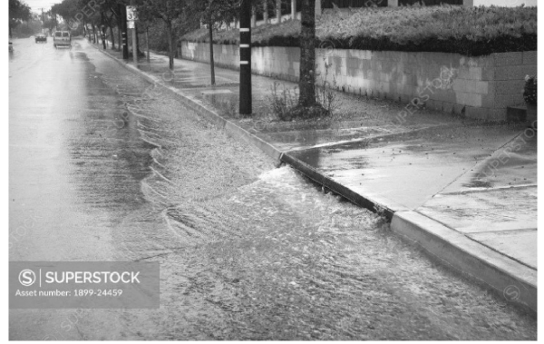
a) Thu nước mưa kết hợp của thu nước kiểu hàm ếch với tấm đan/ghi thu
