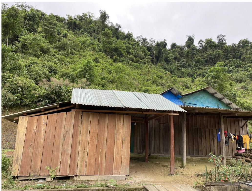
Ngôi nhà mới dựng lại sau trận lũ ở thôn Mít Cát, xã Kim Thủy, huyện Lệ Thủy, tỉnh Quảng Bình
