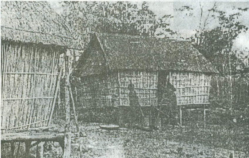
Ảnh 12: Vách nứa bên ngoài có đố dọc và nẹp ngang bằng cây lồ ô được che nghiêng theo thế “thượng thách hạ thu”
