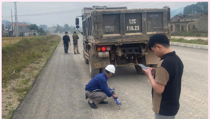
Kiểm tra, kiểm định chất lượng công trình xây dựng: Nâng cấp đoạn Km18-Km80, Quốc lộ 4B
