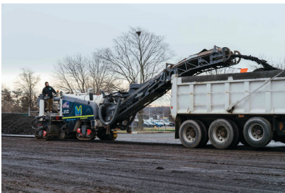
Hình 3: Cào bóc mặt đường cũ
