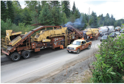
Hình 2: Chuẩn bị mặt bằng
