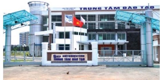
Khu công nghệ cao TP. Hồ Chí Minh - địa điểm lý tưởng cho các hoạt động đầu tư, nghiên cứu công nghệ vi mạch tại Việt Nam.
