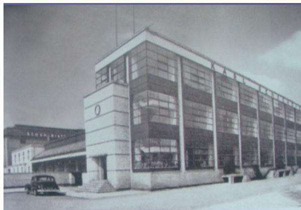
Thiết kế nhà máy Fagus sản xuất khuôn giày ở phía bắc nước Đức của Walter Gropius với ý tưởng độc đáo : “Công trình không trọng lượng” vì không thấy kết cấu cột ở các góc nhà như thiết kế thông thường (Nguồn: Tủ sách nghệ thuật)
