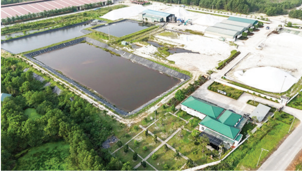
Dự án chế biến cát trắng của Công ty VICO Quảng Trị
