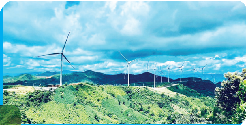
Dự án điện gió ở vùng Tây Quảng Trị
