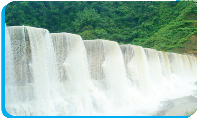
Công trình thủy điện trên sông Đakrông, Quảng Trị.
