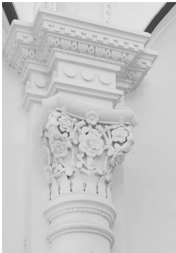
Hình ảnh hoa hồng biểu tượng của Đức Mẹ Maria, điêu khắc tại cột bằng phương pháp đắp vữa - Nhà thờ Bích Trì - Nguồn: Tác giả
