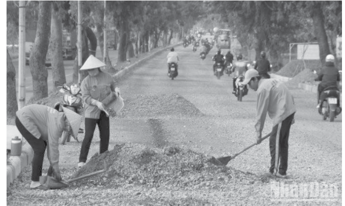
Hình 2. Dự án nâng cấp, mở rộng đường Nguyễn Văn Linh năm 2023
