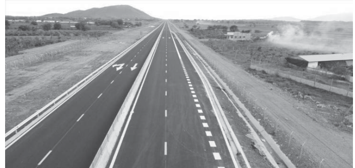
Hình 3. Cao tốc Vĩnh Hảo - Phan Thiết giai đoạn 1, được đầu tư quy mô 4 làn xe, bề rộng nền đường 17m, không có làn khẩn cấp trạm dừng nghỉ
