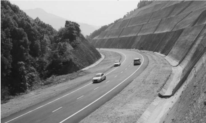
Hình 6. Cao tốc Cam Lộ - La Sơn đoạn không có dải phân cách cứng - không làn khẩn cấp
