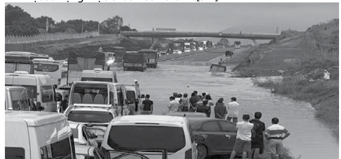
Hình 4. Nước ngập cao tốc đoạn qua xã Sông Phan khiến giao thông ùn tắc xe
