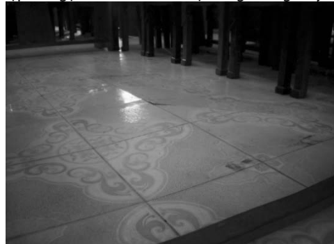
Hình 1. Phồng rộp nền gạch ceramic
