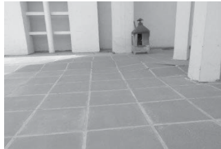
Hình 3. Phồng rộp nền gạch đất sét nung
