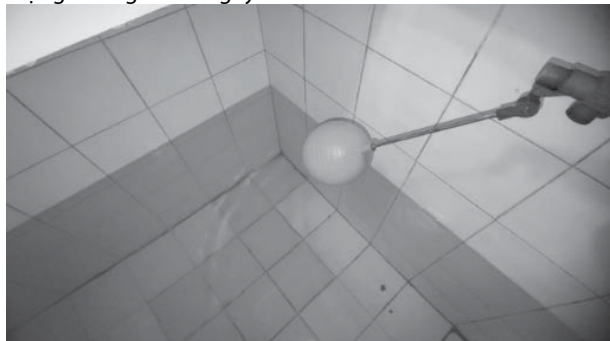
Hình 3. Chống thấm tường và đáy bể nước bằng cách ốp gạch men
