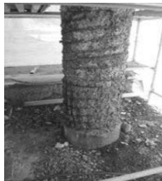
Gia cường các trụ của cầu cảng Venterminales ở Venezuela, trụ cầu có tiết diện tròn có đường kính 50cm, lớp bê tông bảo vệ 10cm bị xâm thực nặng. Lớp UHPC gia cường bên ngoài dày 3cm sử dụng 2% sợi thép. Hoàn thành năm 1992 [19]
