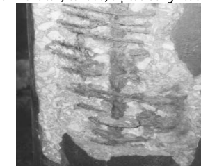
Gia cường các trụ của cầu cảng Venterminales ở Venezuela, trụ cầu có tiết diện tròn có đường kính 50cm, lớp bê tông bảo vệ 10cm bị xâm thực nặng. Lớp UHPC gia cường bên ngoài dày 3cm sử dụng 2% sợi thép. Hoàn thành năm 1992 [19]
