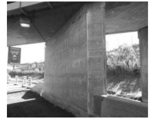
Cầu CN Rail Bridge (Montreal, Quebec, Canada), trụ cầu tiết diện hình chữ nhật cao 3.3m, rộng 8m, dài 7m. Lớp UHPC gia cường dày 10cm. Hoàn thành gia cường tháng 10/2013 [20]
