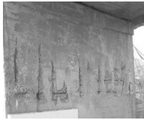
Cầu CN Rail Bridge (Montreal, Quebec, Canada), trụ cầu tiết diện hình chữ nhật cao 3.3m, rộng 8m, dài 7m. Lớp UHPC gia cường dày 10cm. Hoàn thành gia cường tháng 10/2013 [20]
