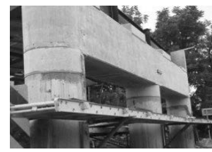
Cầu Hooper Rd (Town of Union, New York, USA), trụ cầu tiết diện tròn có đường kính 1.07m được gia cường bởi lớp UHPC tại vị trí kết nối với kết cấu xà mũ. Hoàn thành tháng 9/2014 [20]
