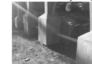
Cầu Haqwilget Bridge, New Hazelton, Canada, trụ cầu bằng kết cấu thép hình được gia cường bởi lớp UHPC tại chân cột và hoàn thành năm 2015 [20]
