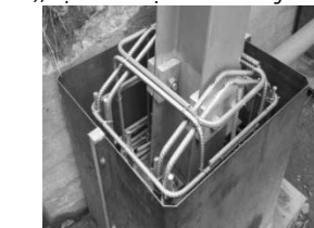
Cầu Haqwilget Bridge, New Hazelton, Canada, trụ cầu bằng kết cấu thép hình được gia cường bởi lớp UHPC tại chân cột và hoàn thành năm 2015 [20]
