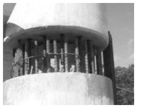
Cầu Hooper Rd (Town of Union, New York, USA), trụ cầu tiết diện tròn có đường kính 1.07m được gia cường bởi lớp UHPC tại vị trí kết nối với kết cấu xà mũ. Hoàn thành tháng 9/2014 [20]
