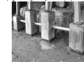
Cầu Haqwilget Bridge, New Hazelton, Canada, trụ cầu bằng kết cấu thép hình được gia cường bởi lớp UHPC tại chân cột và hoàn thành năm 2015 [20]
