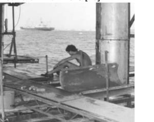
Gia cường các trụ của cầu cảng Venterminales ở Venezuela, trụ cầu có tiết diện tròn có đường kính 50cm, lớp bê tông bảo vệ 10cm bị xâm thực nặng. Lớp UHPC gia cường bên ngoài dày 3cm sử dụng 2% sợi thép. Hoàn thành năm 1992 [19]
