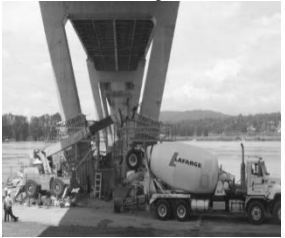
Cầu Mission Bridge (Abbotsford, British Columbia, Canada), trụ cầu gồm 2 chữ V tiết diện hình chữ nhật 2.1 x 2.6m, cao 3.2m. Lớp UHPC gia cường dày 22.5cm kết hợp với các neo thép (rebar) tạo dính bám giữa bê tông cũ và UHPC. Hoàn thành gia cường tháng 6/2014 [20]
