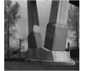
Cầu Mission Bridge (Abbotsford, British Columbia, Canada), trụ cầu gồm 2 chữ V tiết diện hình chữ nhật 2.1 x 2.6m, cao 3.2m. Lớp UHPC gia cường dày 22.5cm kết hợp với các neo thép (rebar) tạo dính bám giữa bê tông cũ và UHPC. Hoàn thành gia cường tháng 6/2014 [20]
