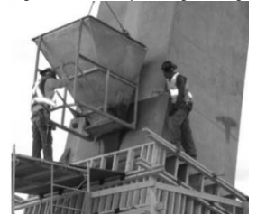
Cầu Mission Bridge (Abbotsford, British Columbia, Canada), trụ cầu gồm 2 chữ V tiết diện hình chữ nhật 2.1 x 2.6m, cao 3.2m. Lớp UHPC gia cường dày 22.5cm kết hợp với các neo thép (rebar) tạo dính bám giữa bê tông cũ và UHPC. Hoàn thành gia cường tháng 6/2014 [20]
