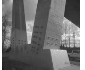
Cầu Mission Bridge (Abbotsford, British Columbia, Canada), trụ cầu gồm 2 chữ V tiết diện hình chữ nhật 2.1 x 2.6m, cao 3.2m. Lớp UHPC gia cường dày 22.5cm kết hợp với các neo thép (rebar) tạo dính bám giữa bê tông cũ và UHPC. Hoàn thành gia cường tháng 6/2014 [20]
