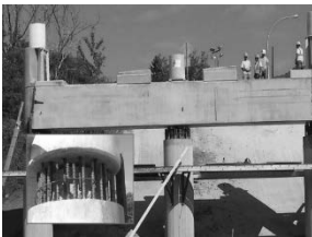
Cầu Hooper Rd (Town of Union, New York, USA), trụ cầu tiết diện tròn có đường kính 1.07m được gia cường bởi lớp UHPC tại vị trí kết nối với kết cấu xà mũ. Hoàn thành tháng 9/2014 [20]
