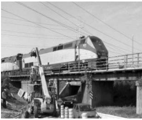
Cầu CN Rail Bridge (Montreal, Quebec, Canada), trụ cầu tiết diện hình chữ nhật cao 3.3m, rộng 8m, dài 7m. Lớp UHPC gia cường dày 10cm. Hoàn thành gia cường tháng 10/2013 [20]
