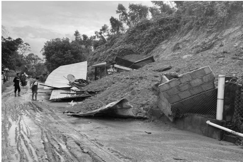
Hình 3. Hình ảnh về sạt lở đất, đá
