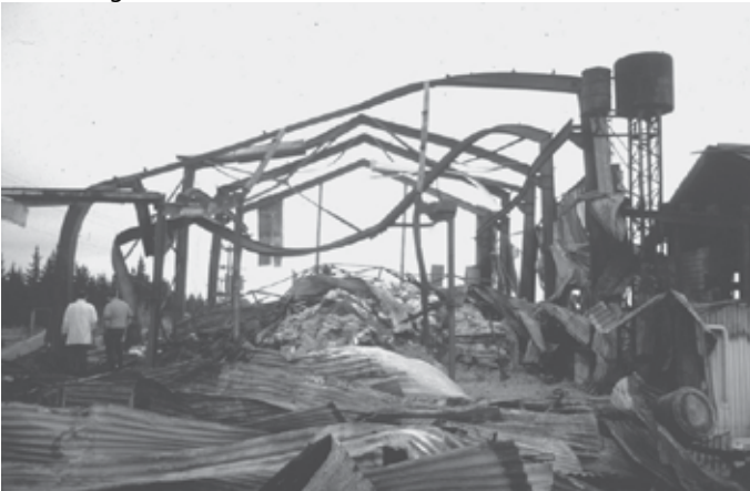
Hình 1. Minh họa nhà thép bị sụp đổ do tác động của cháy (nguồn figure 6.1 [6])
