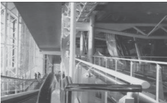
Hình 6. Sơn chống cháy bảo vệ kết cấu thép
