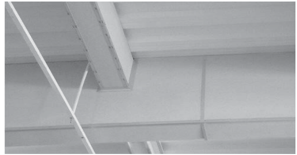
Hình 4. Bọc thạch cao chuyên dụng bảo vệ kết cấu thép
