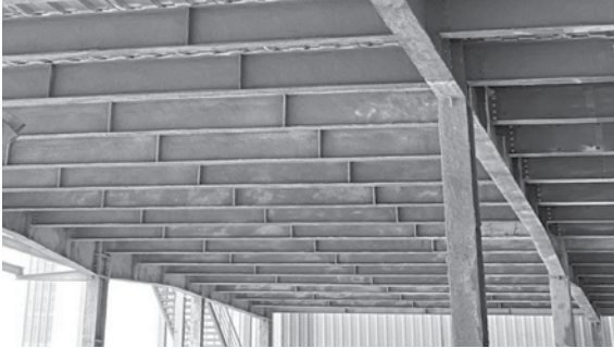
Hình 5. Phun vữa chống cháy bảo vệ kết cấu thép
