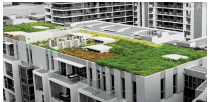
Hình 2. Áp dụng mô hình mái xanh thu gom nước tại Rummelsburg, Berlin, CHLB Đức. Các chung cư và nhà cao tầng được phủ xanh và có hệ thống thu gom nước dẫn xuống bể ngầm dưới chân công trình.
