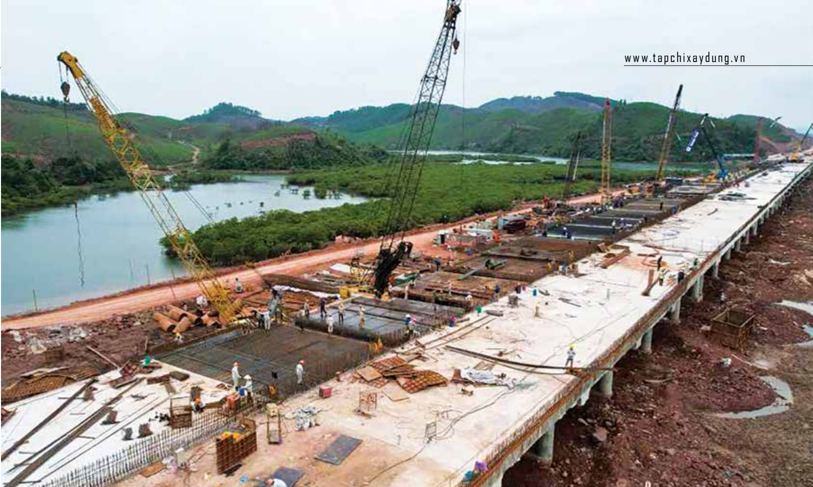
Quá trình thi công xây dựng cầu Đà Xuyên trên cao tốc Vân Đồn - Tiên Yên, tỉnh Quảng Ninh.
