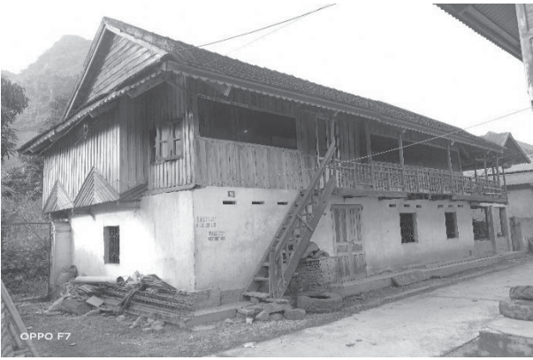
Nhà ở dân tộc Lào tại tỉnh Điện Biên
