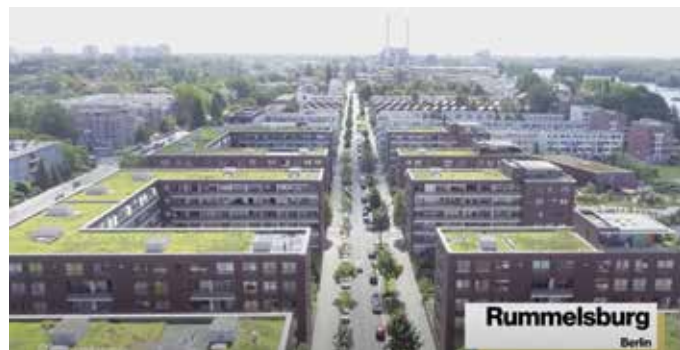
Hình 2. Áp dụng mô hình mái xanh thu gom nước tại Rummelsburg, Berlin, CHLB Đức. Các chung cư và nhà cao tầng được phủ xanh và có hệ thống thu gom nước dẫn xuống bể ngầm dưới chân công trình.
