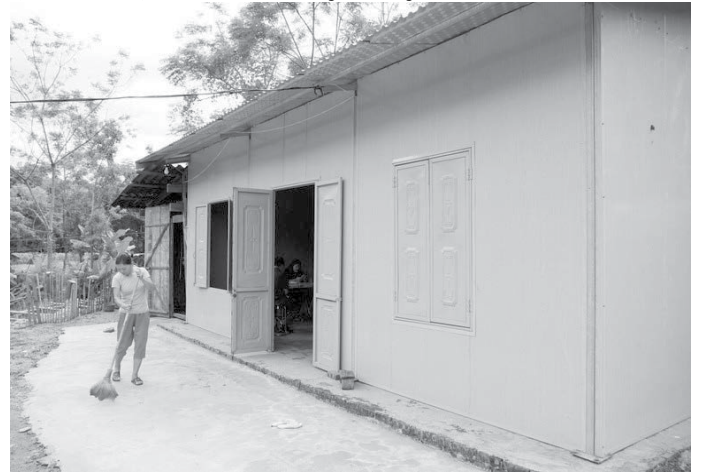
Hình 5. Ngôi nhà mới của gia đình bà Ninh Thị Thập, thôn Nà Đúc, xã Địa Linh, huyện Ba Bể, Bắc Kạn được hỗ trợ xây dựng theo chương trình xóa nhà tạm, nhà dột nát [14]
