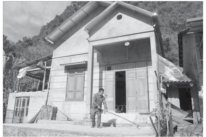
Hình 4. Nhà ở mới được hỗ trợ xây dựng theo chương trình xóa nhà tạm, nhà dột nát tại thôn Kéo Sĩ, thị trấn Thanh Nhật, Hạ Lang, Cao Bằng [13]
