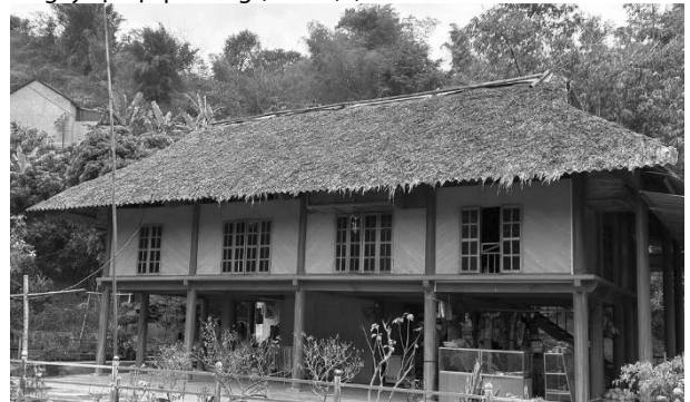
Hình 3. Ngôi nhà sàn mới được xây bằng kết cấu bê tông cốt thép, tường xây gạch không nung sơn giả gỗ, mái lợp lá cọ đã kế thừa được giá trị kiến trúc truyền thống nhưng vẫn đáp ứng cuộc sống hiện đại của người dân [8]
