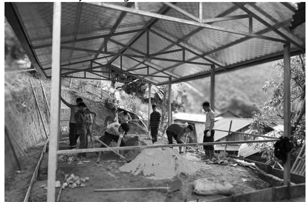
Hình 2. Kết cấu ngôi nhà theo kiến trúc mới được sử dụng kết cấu khung thép hình, mái lợp tôn là những loại vật liệu xa lạ với văn hóa kiến trúc truyền thống dân tộc La Hủ tại xã Pa Vệ Sủ, huyện Mường Tè, tỉnh Lai Châu [16]
