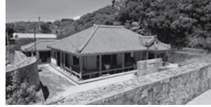
Nhà ở người dân Boatman's House trên đảo Geruma. Ban đầu là mái nhà tranh, sau được chỉnh sửa bằng mái ngói đỏ vào thời Taisho, được xây dựng cuối TK19. [11]
