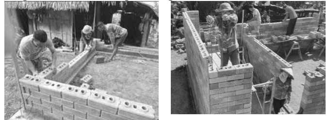
Hình 15. Hướng dẫn thi công xây dựng tường bằng gạch đất không nung
