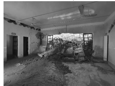
Hiện trạng điểm trường bị lũ, sạt lở tại Bát Sắt, Lào Cai. Nguồn: daibieunhandan.vn
