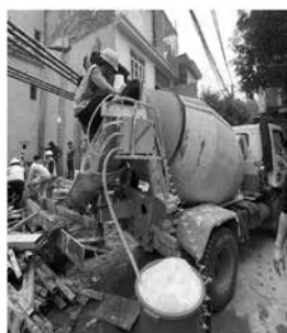
Hình 2. Xe bồn trút bê tông vào móng
