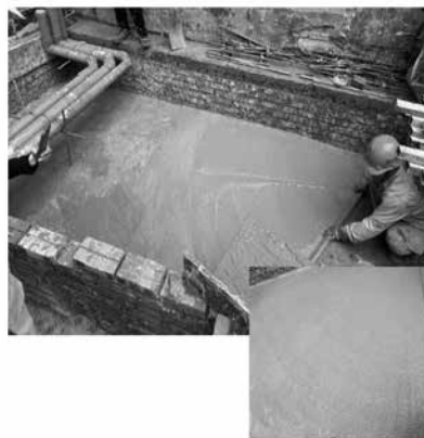
Hình 3. Hố móng khi lấp bằng bê tông
