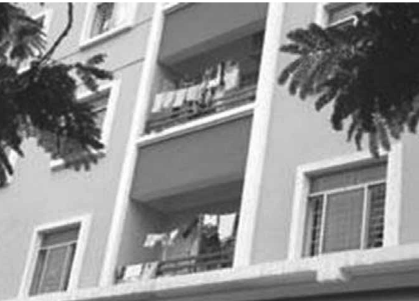
Nhà chung cư có cấu tạo lan can logia gây nguy hiểm cho trẻ nhỏ
