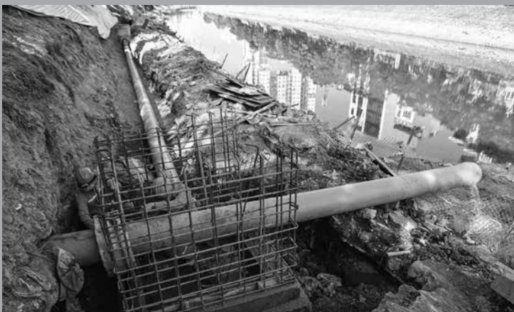
Xây dựng cống gom nước thải
