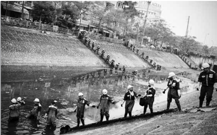
Nạo vét vãn bằng phương pháp thủ công
