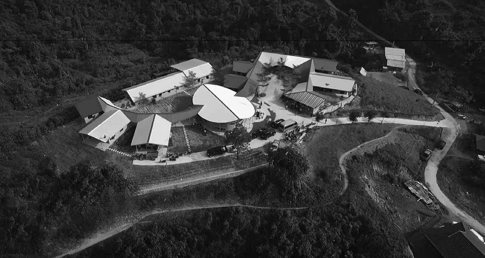
Công trình Trường tiểu học Lũng Luông (Thái Nguyên) của KTS Hoàng Thúc Hào.
