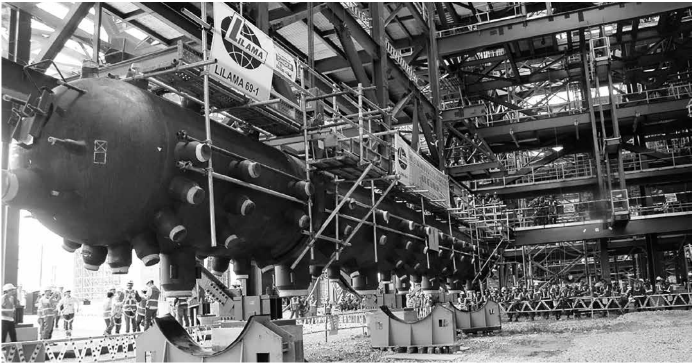
Lắp đặt Bao hơi nhà máy điện nhiệt điện
