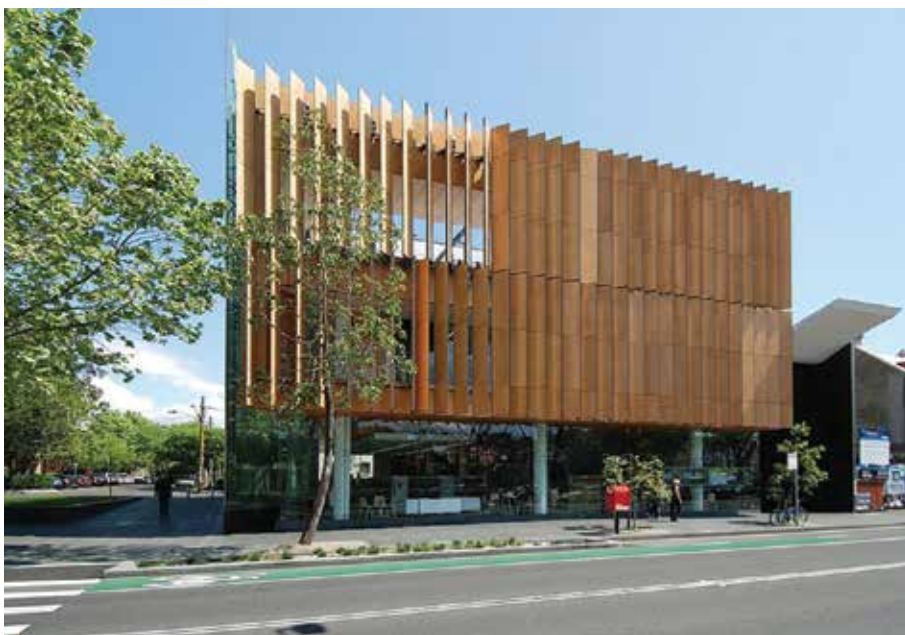
Hình 3. Mặt dựng đóng mở tự động ở Trung tâm Thư viện và Cộng đồng Surry Hills, Sydney (Giấy phép: creative common).
