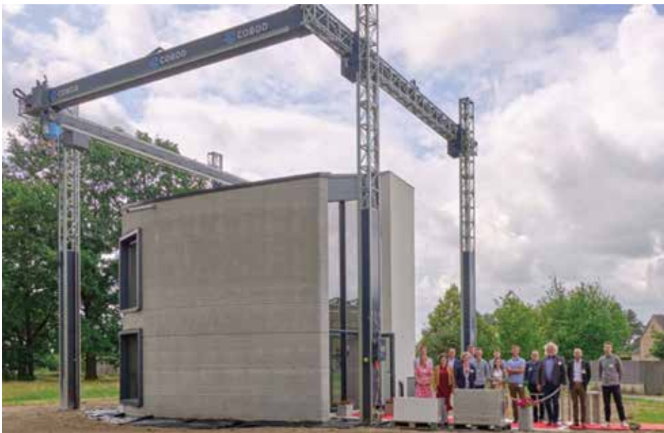
Hình 9. Ngôi nhà được in 3D bởi máy in 3D COBOD gồm một khối 2 tầng khoảng 90 m 2 trong 3 tuần tại Bỉ năm 2020 (nguồn ảnh: [6])
