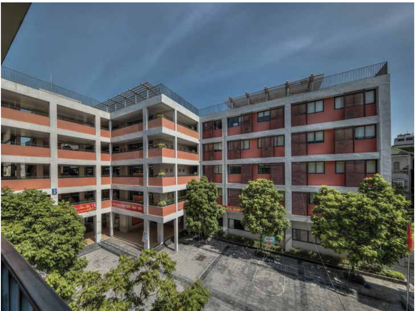
Tổng thể tổ chức các khối chức năng liên hoàn trường Tiểu học Chu Văn An (Tây Hồ, Hà Nội)
