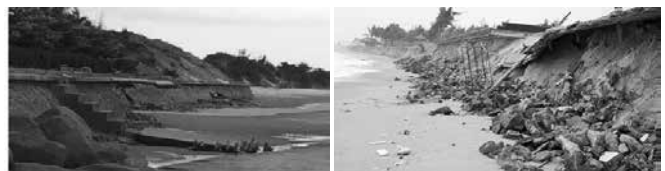
Hình 2. Kè xây đá học tại bờ biển khu nghỉ dưỡng Long Cung và Sao Việt Non Nước
