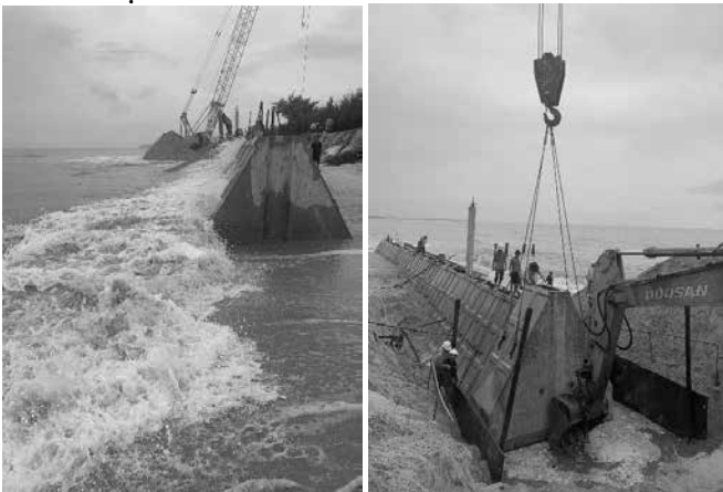
Hình 13. Lắp đặt cấu kiện kè
