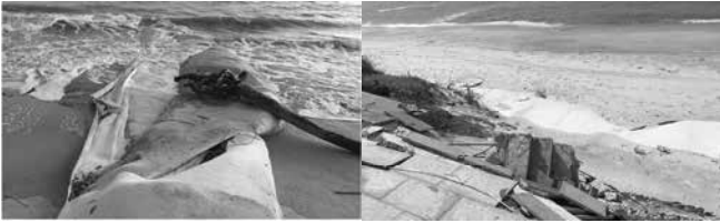
Hình 3. Mô hình bằng ống Geotube tại bờ biển Lộc An và bờ biển Làng Chài
