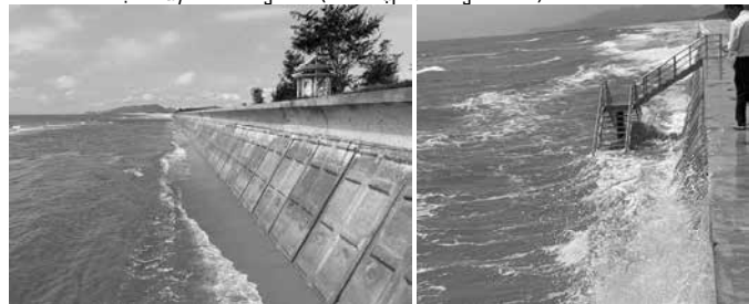
Hình 6. Hình ảnh tuyến kè sử dụng cấu kiện bê tông cốt sợi thành mảng sau khi hoàn thành
