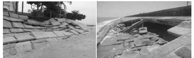
Hình 1. Tấm lát bê tông tại bờ biển Hồ Tràm và bờ biển Hội An
