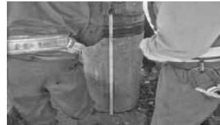
Hình 19a. Hàn cao từ 900mm đến 1200mm
