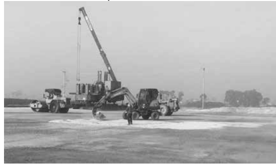
Hình 1: Sử dụng cát và đá dăm san nền, lu lèn và làm phẳng mặt bằng phục vụ thi công
