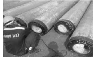
Hình 18a. Dây cọc thứ 2 và các đoạn kế tiếp cần nối phải được làm sạch
