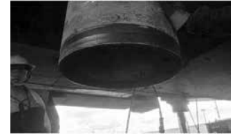
Hình 18b. Dây của đoạn cọc tiếp theo được làm sạch
