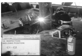
Hình 21a. Công tác hàn
