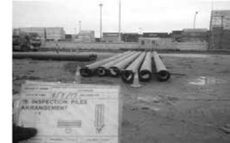
Hình 10: Xếp cọc 1 hàng trên mặt bằng thi công
