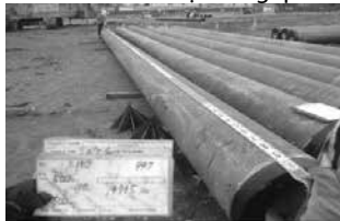
Hình 2: Kiểm tra chiều dài cọc
