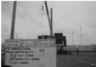
Hình 15a: Dùng dây dọi để kiểm tra độ thẳng đứng theo phương X
