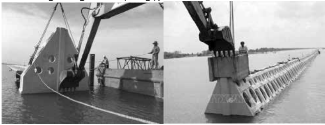
Hình 13. Thi công kè giảm sóng tại biển Tây - Cà Mau
