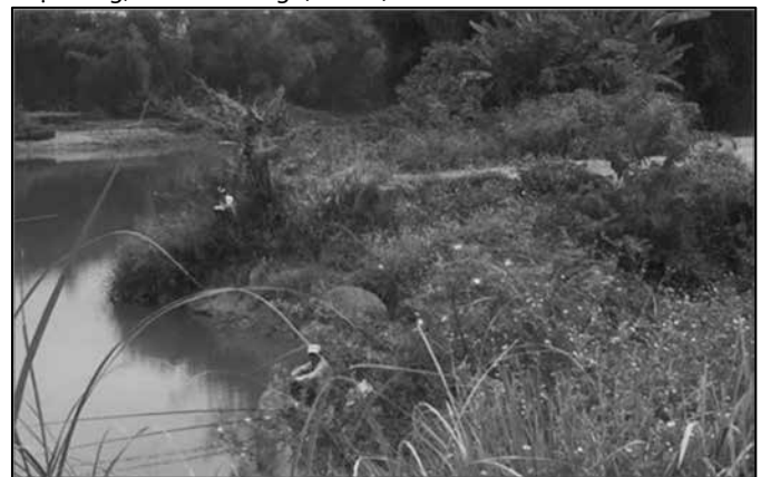
Hình 2: Hiện trạng sạt lở khoảng 20m bờ sông khu vực xã Hòa Phong
