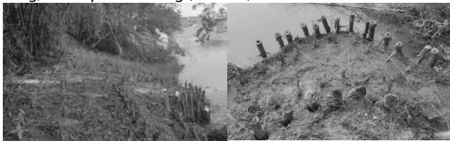
Hình 12: Gia cố bờ sông bằng cỏ Vetiver xã Hòa Phong, Đà Nẵng
