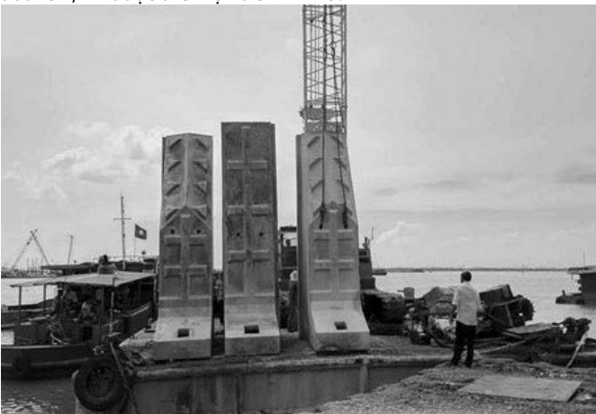
Hình 5. Mặt trước và sau cấu kiện kè 5m
