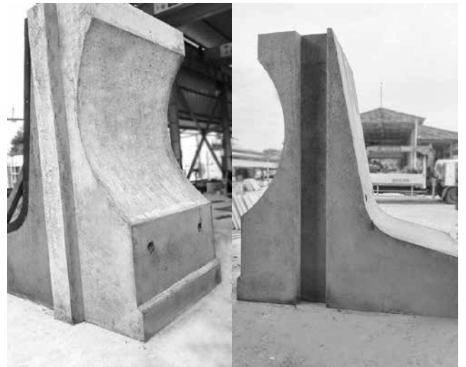
Hình 7. Hình dạng tường hắt sóng
