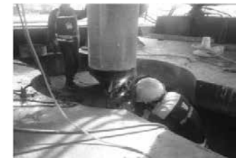
Hình 13: Đầu cọc được kiểm tra chất lượng và hàn lại trước khi lắp đặt
