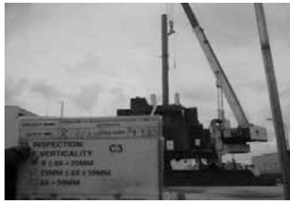
Hình 15b: Dùng dây dọi để kiểm tra độ thẳng đứng theo phương Y
