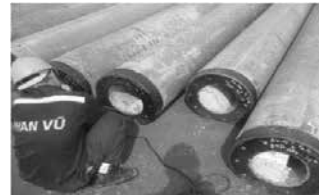
Hình 18a. Đầu cọc thứ 2 và các đoạn kế tiếp cần nối phải được làm sạch
