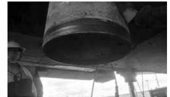
Hình 18b. Đầu của đoạn cọc tiếp theo được làm sạch
