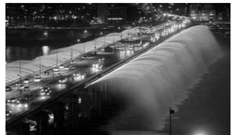
Cầu Banpo Girder, Hàn Quốc
