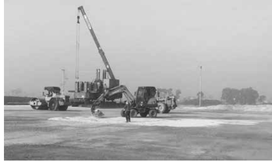
Hình 1: Sử dụng cát và đá dăm san nền, lu lèn và làm phẳng mặt bằng phục vụ thi công
