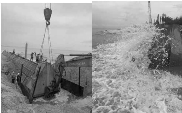
Hình 14. Thi công kè bảo vệ bờ tại bờ biển khu du lịch Lăng Chài - tỉnh Bà Rịa - Vũng Tàu
