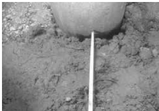
Hình 14a. Vị trí cọc cần kiểm tra kỹ khi cọc được lắp đặt sâu 1m
