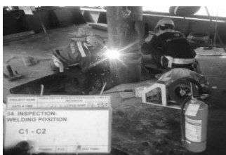
Hình 21a. Công tác hàn
