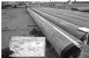
Hình 2: Kiểm tra chiều dài cọc
