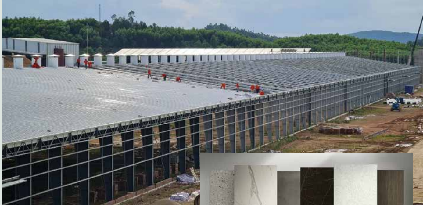
Nhà máy sản xuất sản xuất gạch ốp lát khổ của Công ty Trung Đô đang được xây dựng.
