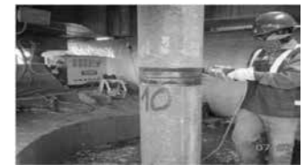
Hình 19b. Công tác làm sạch bề mặt bằng máy chà trước khi hàn mối nối
