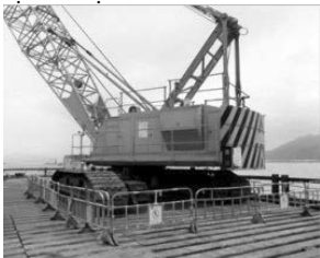
Hình 3: Rào chắn khu vực thi công [7]
