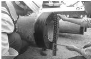
Hình 4: Kiểm tra bề mặt của đầu cọc theo phương ngang và chi tiết đầu cọc.
