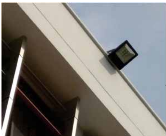
Sử dụng đèn Led pha thay thế cho đèn HPS, đèn Natri cao áp
