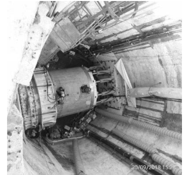
Hình 3. Quá trình kích cống trong giếng đứng
