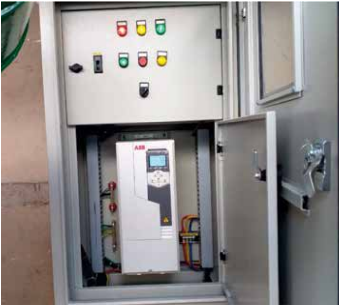
Sử dụng Inverter điều khiển lưu lượng bơm nước lạnh, quạt AHU
