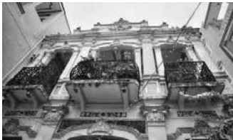
Nhà ở Làng cổ Long Tuyền Số 90 đường Bùi Hữu Nghĩa, Q. Bình Thủy
