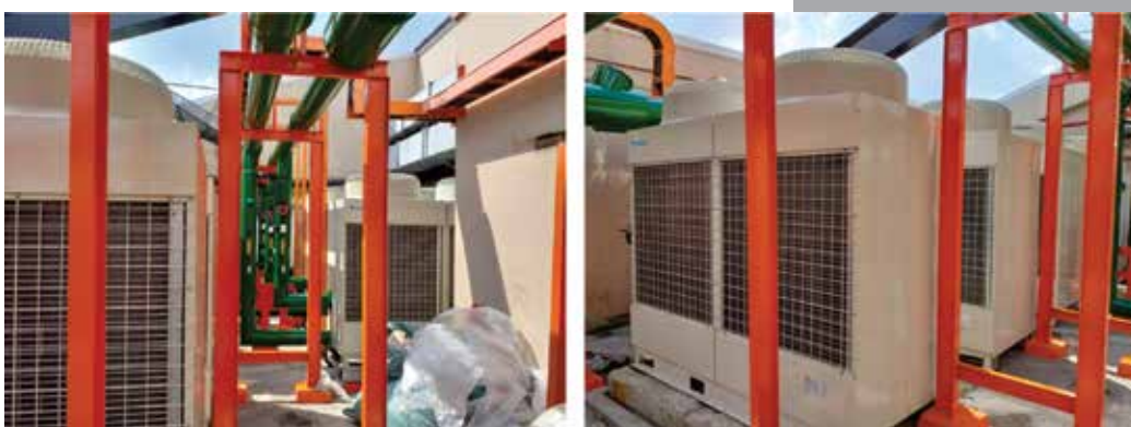
Sử dụng máy lạnh trung tâm hiệu suất cao, có tích hợp Inverter
