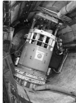
Hình 2. Giếng đứng và thiết bị kích
