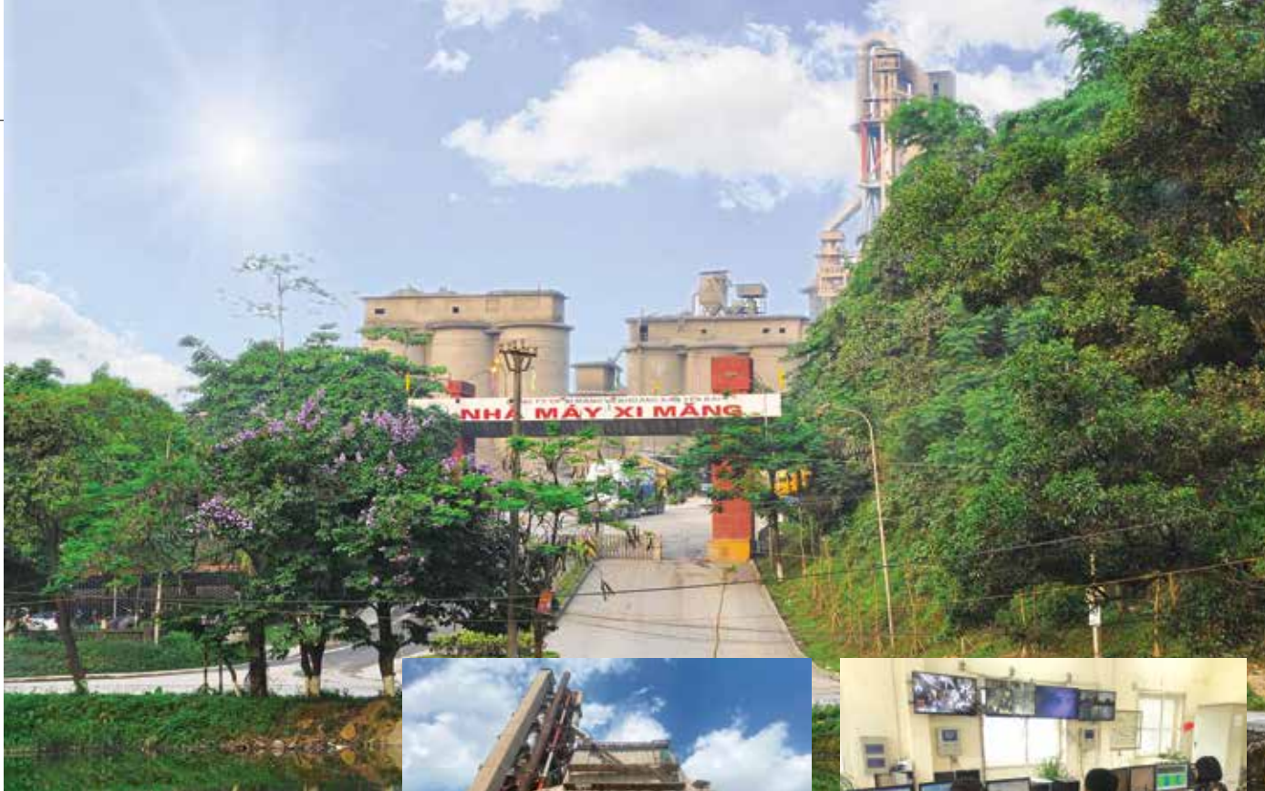
Toàn cảnh Nhà máy Xi măng Yên Bái.
