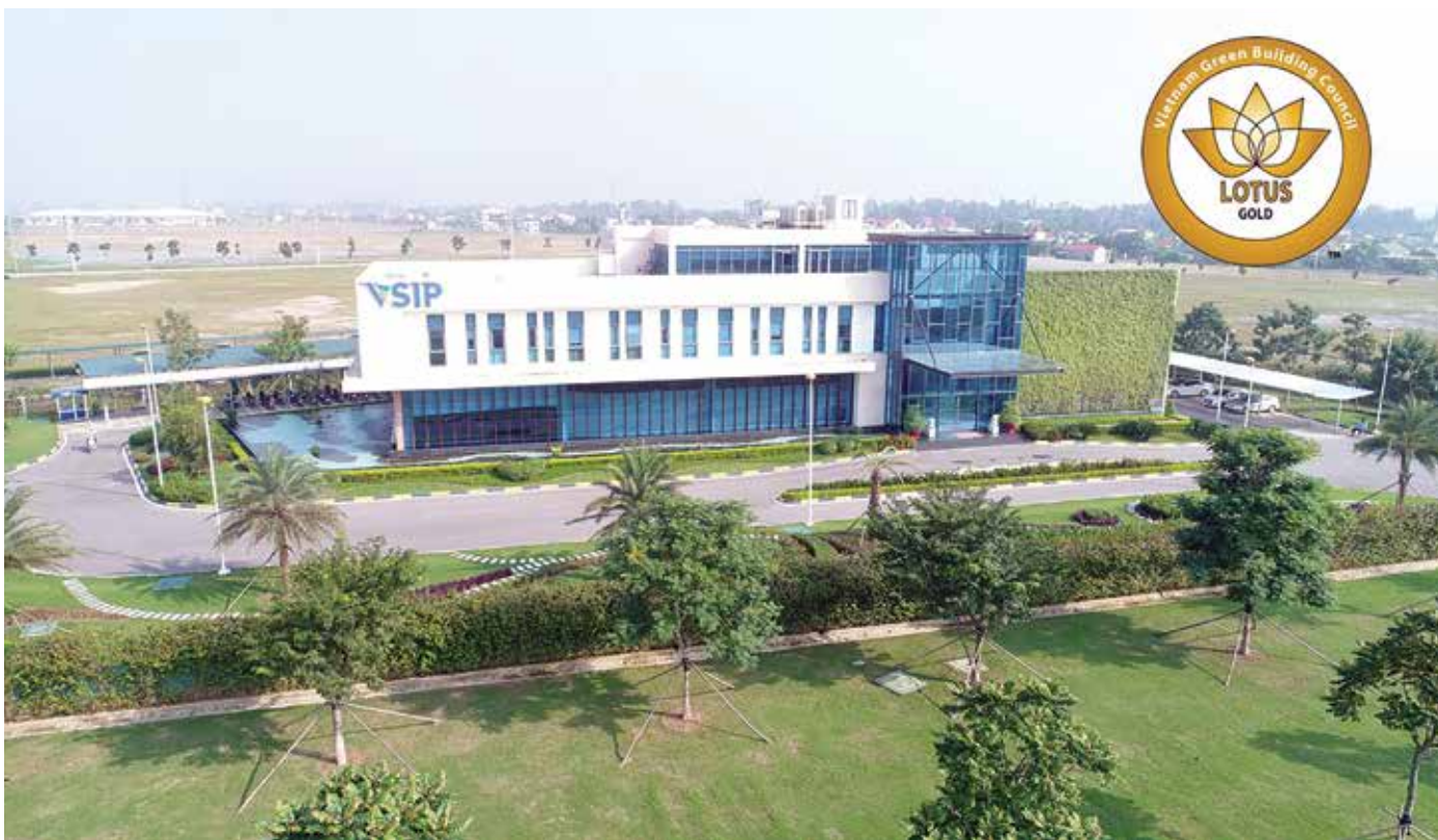
Trụ sở VSIP Nghệ An đạt Chứng nhận Công trình xanh LOTUS Gold
